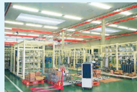
ユニット組立風景
