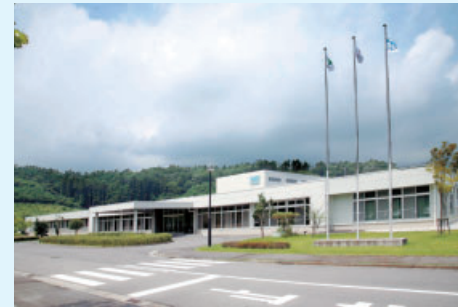
管理棟増築後
