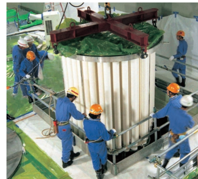
復水ろ過装置設置風景（国内例）
