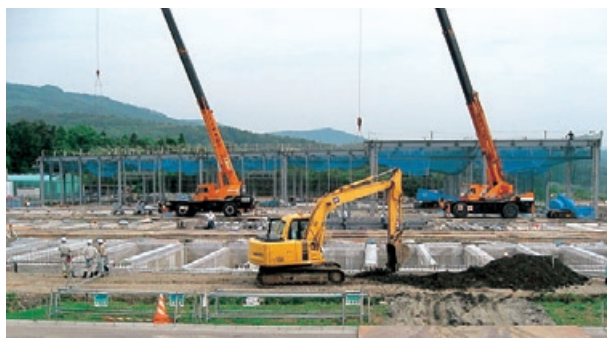
いわき工場新棟建設風景
